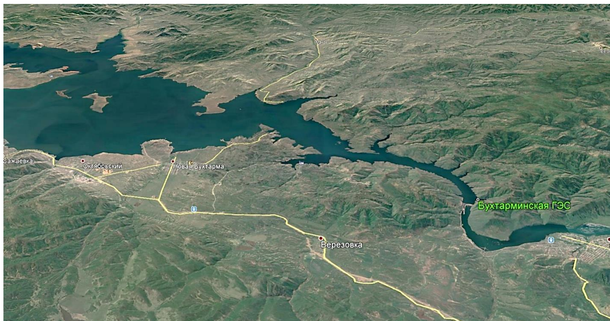
Рис.1.2. Космоснимок Бухтарминского водохранилища
