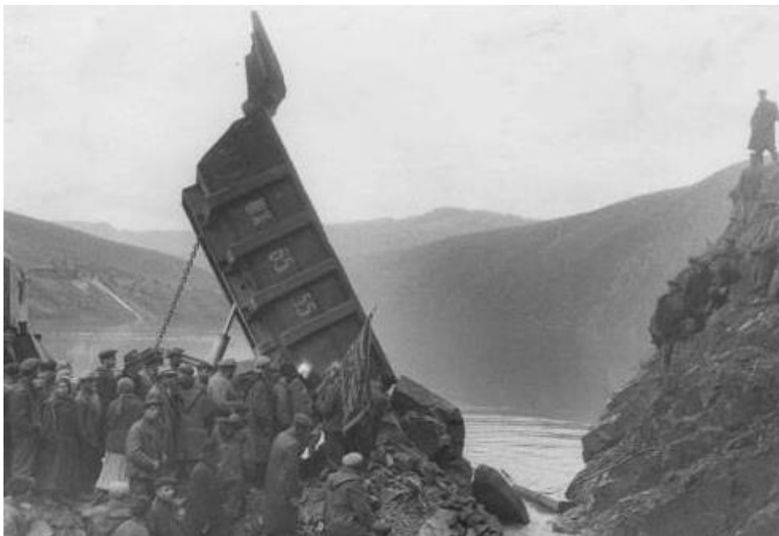
Рис.6.1. Перекрытие русла реки Иртыш.
