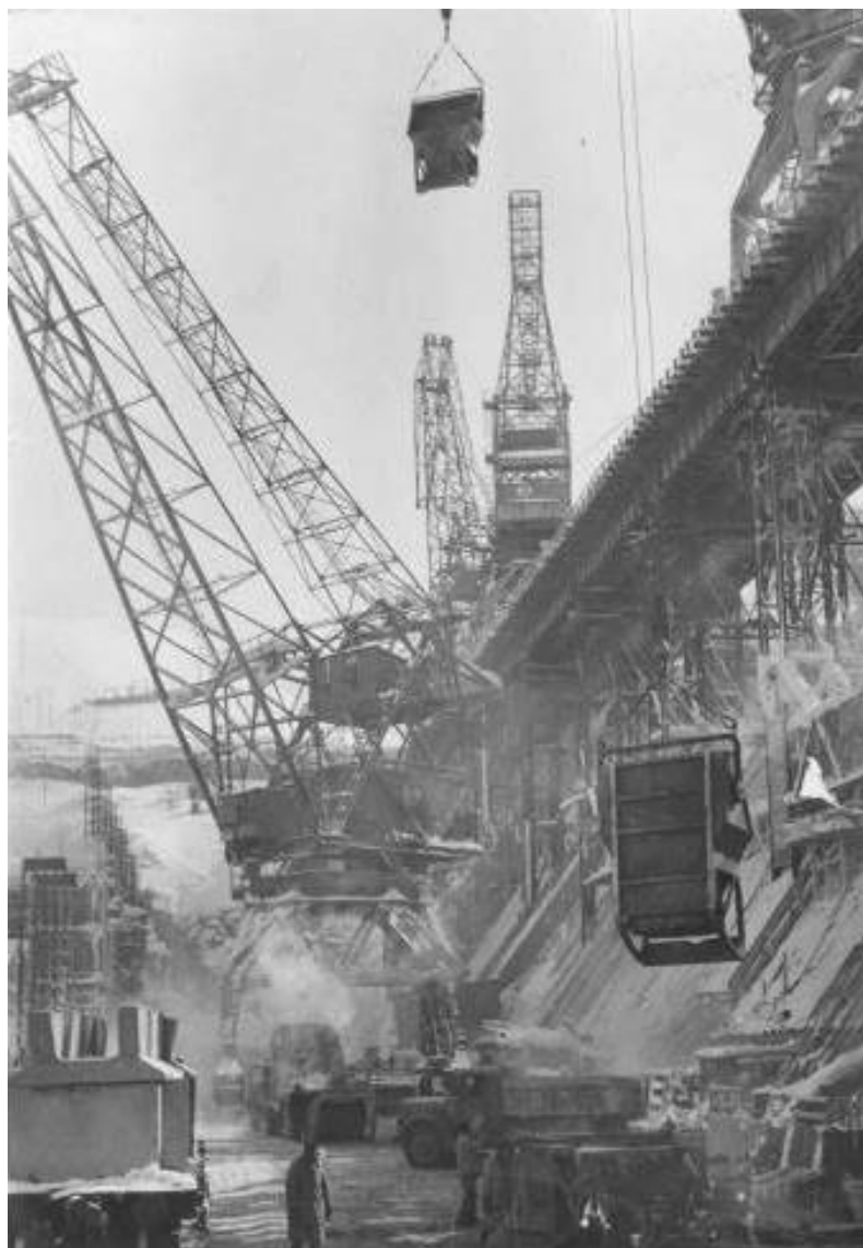
Рис.6.3. Укладка бетона в тело плотины.
