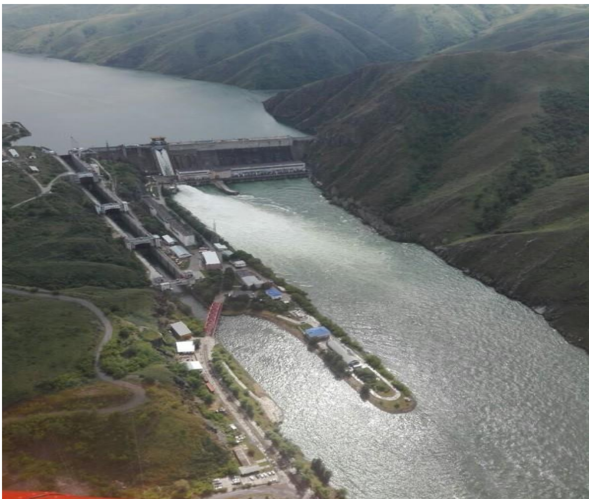
Рис.3.1. Вид на плотину Бухтарминской ГЭС.
