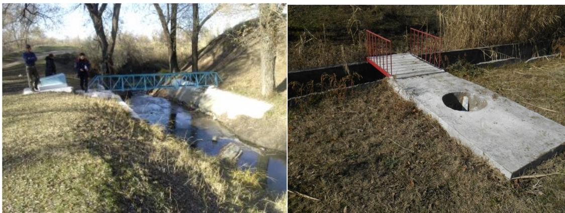
Рис.10. Гидрометрический пост с мостиком и колодцем.
