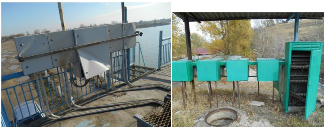
Рис. 9. Пульты автоматического управления затворами.
