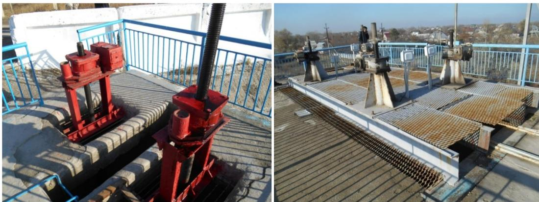
Рис.8. Механизмы подъема плоских затворов
