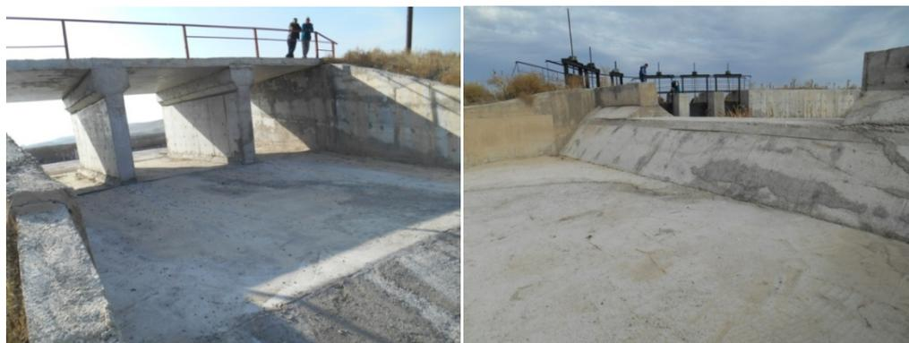
Рис. 7. Аварийный водосброс с широким порогом построенный после реконструкции.
