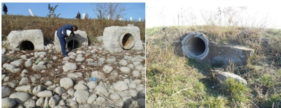
Рис.6. Аварийные водосбросы трубчатые, вид с верхнего бьефа.
