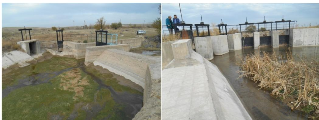
Рис.5. Малые гидроузлы. Верхний бьеф. Особенность малых гидроузлов это простота управления, частое заиливание подводящего русла.
