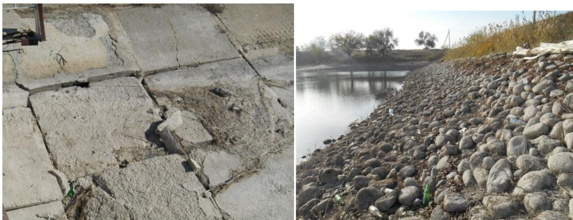
Рис.1. Плотины с железобетонным и каменным креплением откосов.
