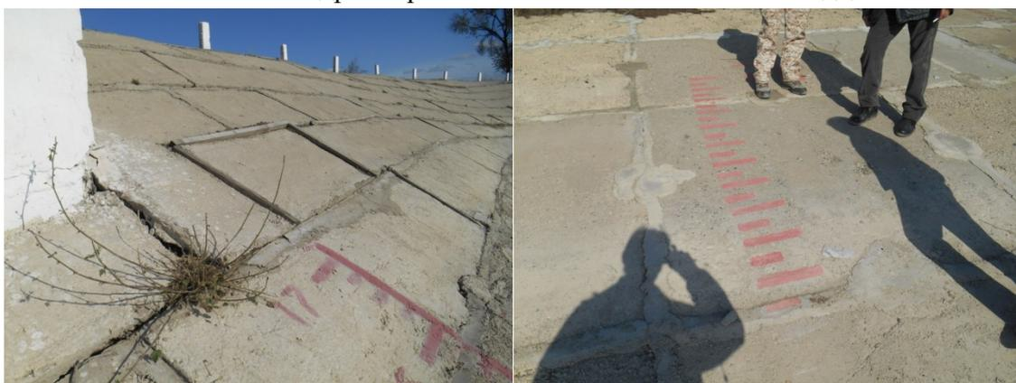
Рис.11. Гидрометрические рейки на откосах плотин.
