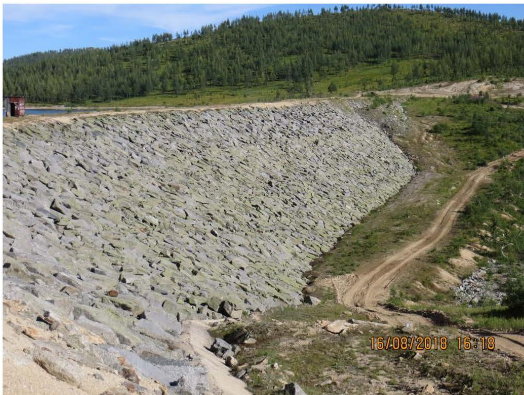
Рис.1. Каменно набросная плотина. Нижний бьеф.
