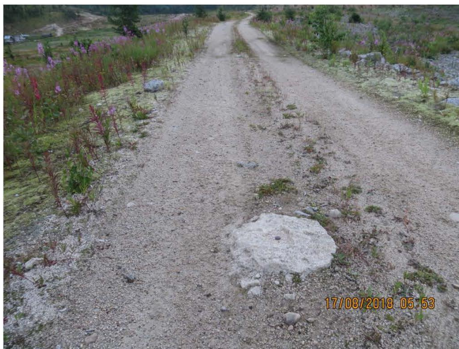
Рис.11. Геодезические марки на гребне плотины №1.
