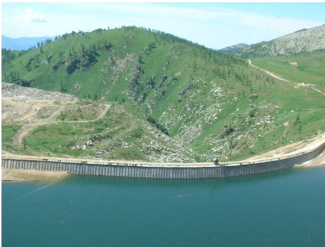
Рис.10.1. Вид на каменно-набросную плотину водохранилища.
