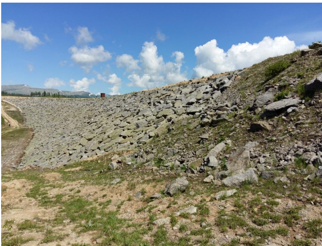
Рис.10.5. Вид нижнего бьефа каменно-набросной плотины.
