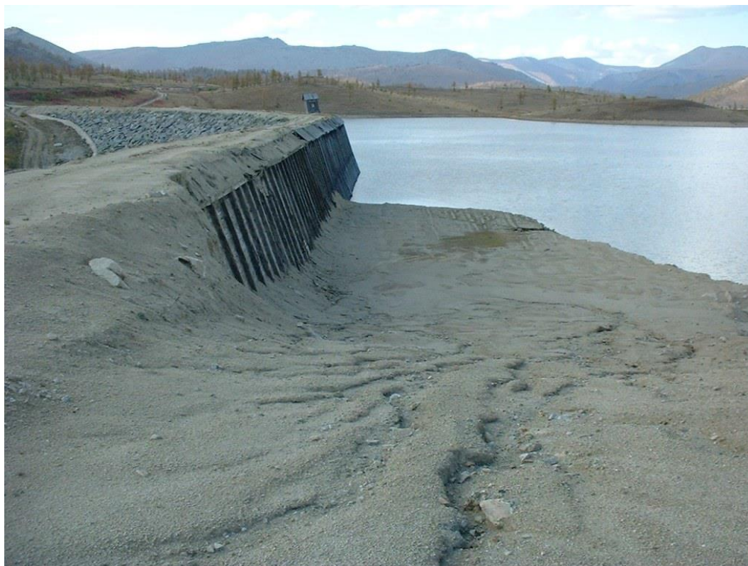
Рис.10.2. Вид на каменно-набросную плотину водохранилища.
