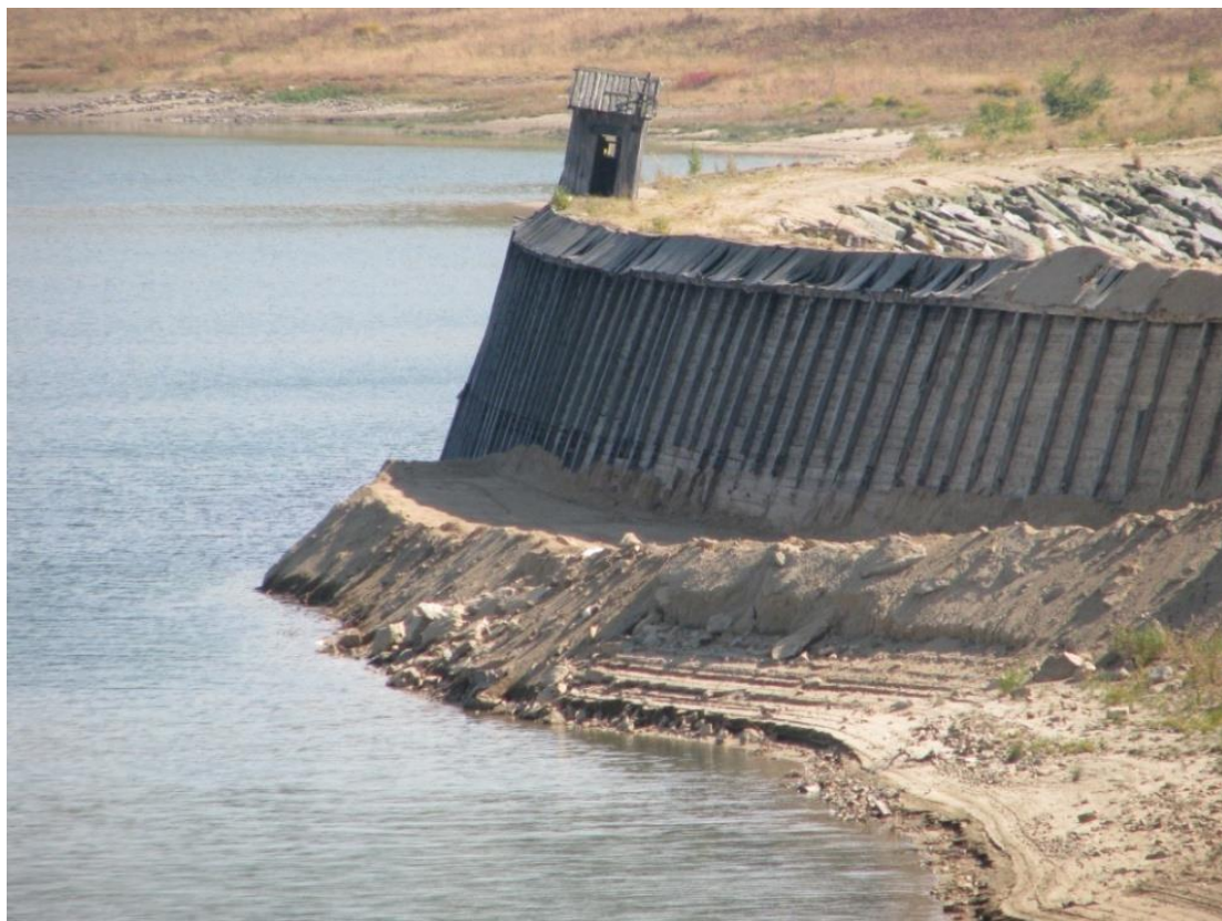
Рис.10.4. Вид на каменно-набросную плотину водохранилища.
