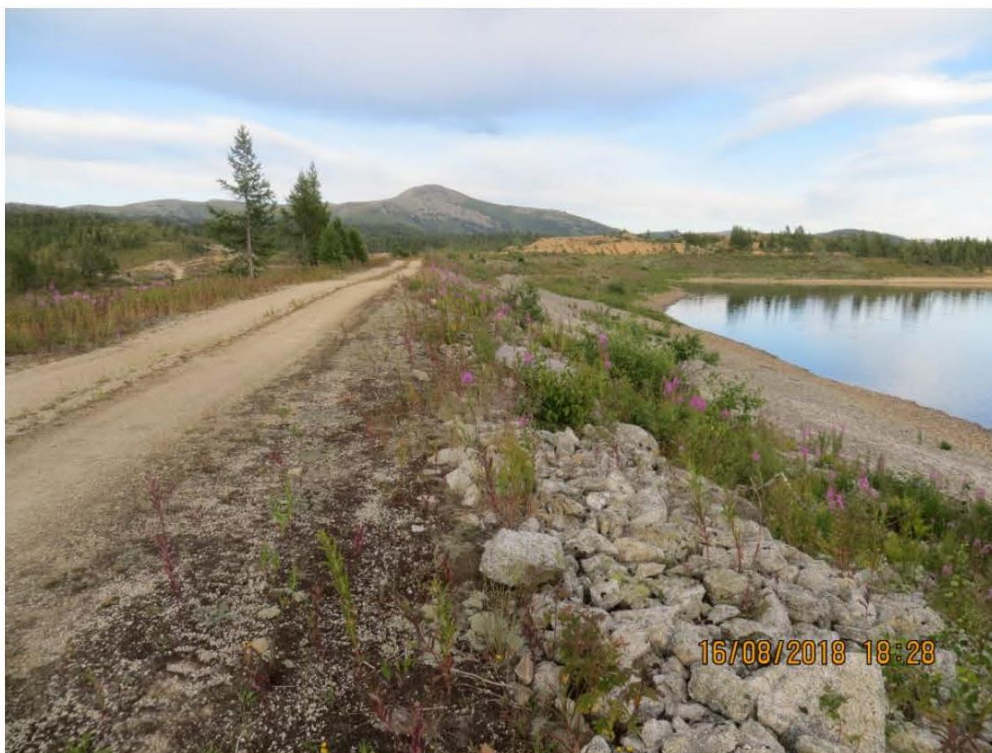
Рис.9. Плотина №2. Гребень плотины и верховой откос, каменное крепление.
