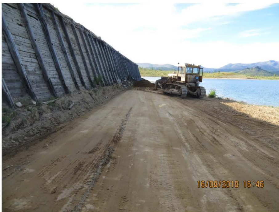
Рис.15. Проведение работ по реконструкции каменно-набросной плотины. Отсыпка верхового откоса.
