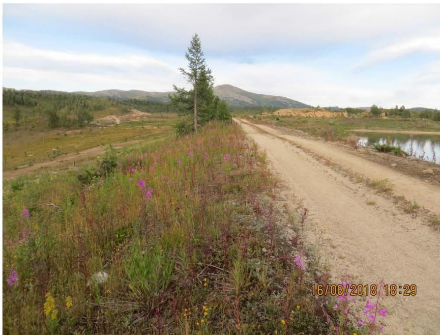
Рис.10. Плотина №2. Гребень плотины и низовой откос с посевами трав на откосе.
