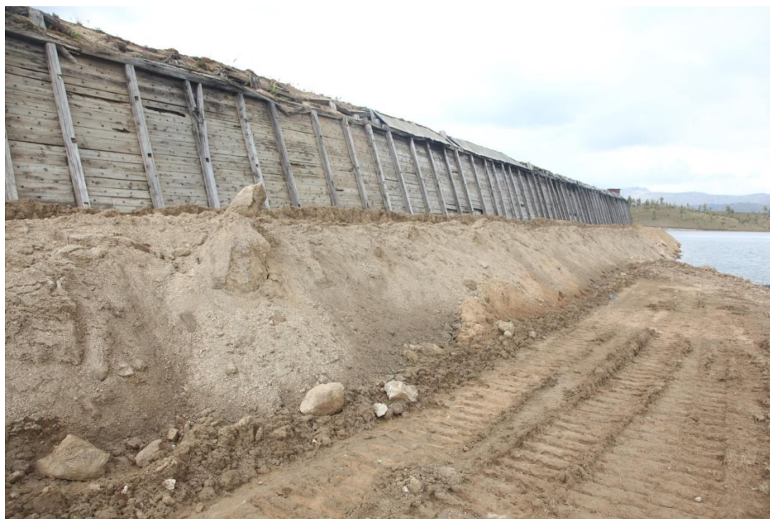
Рис.10.3. Вид на каменно-набросную плотину водохранилища.
