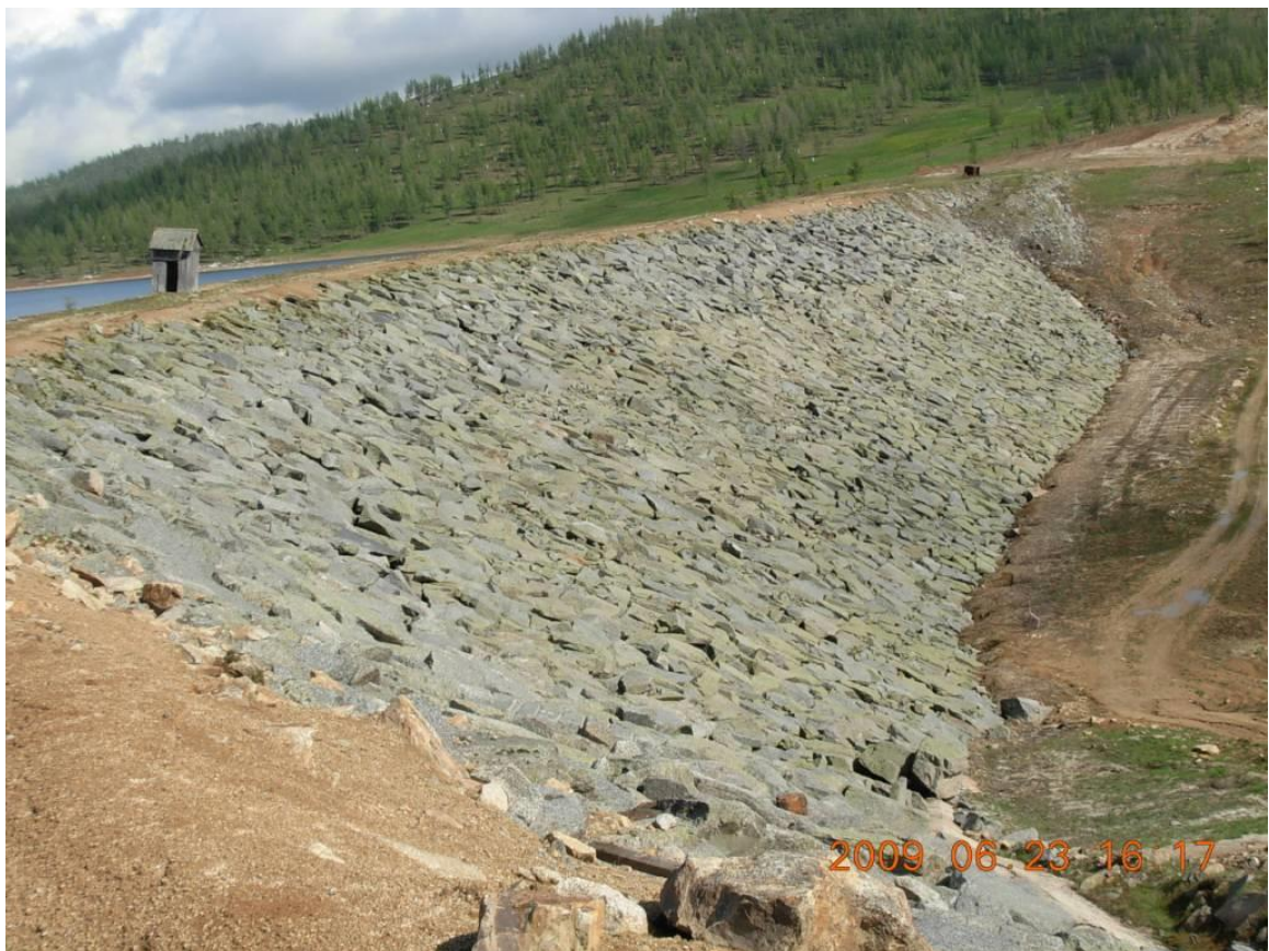
Рис.10.6. Вид нижнего бьефа каменно-набросной плотины.
