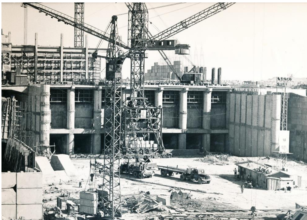
Рис.10.Строительство гидроэлектростанции, нижний бьеф ГЭС.
