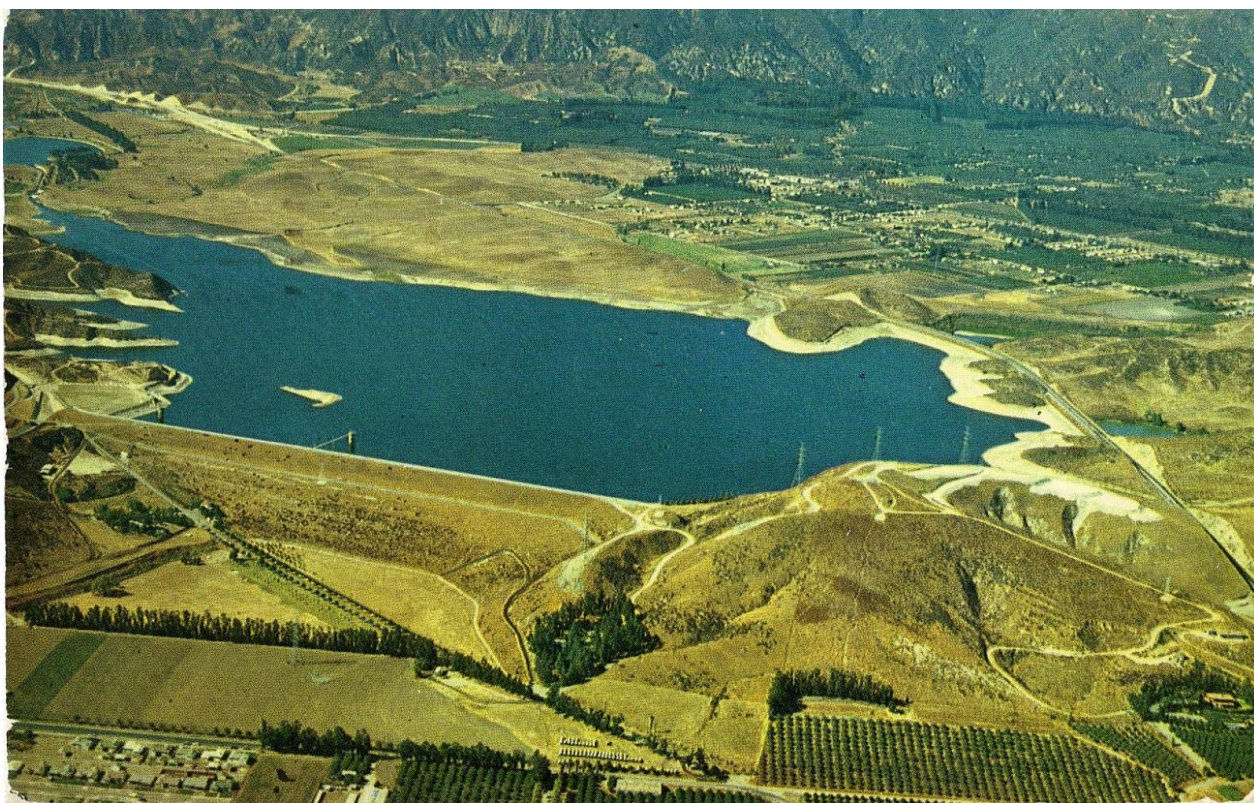
Рис.4.1. Плотина Сан-Фернандо – до землетрясения.
