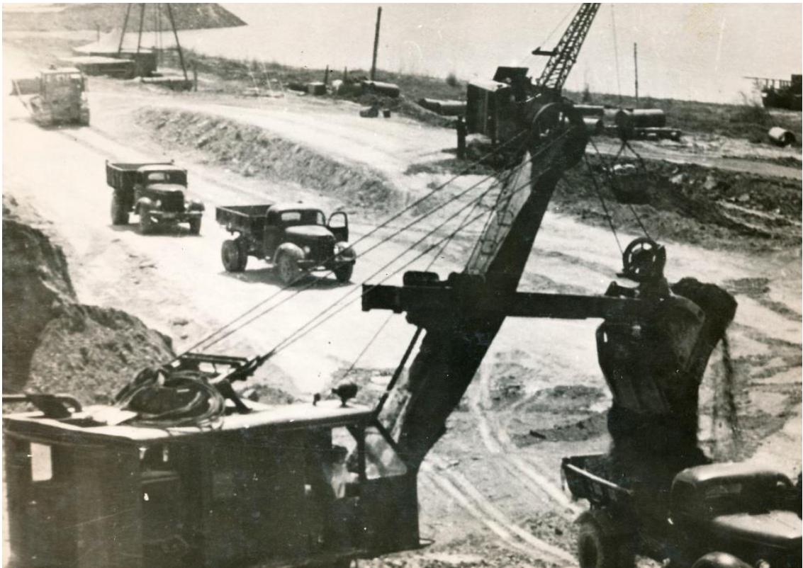
Рис.4.Транспортировка грунта при строительстве плотины.
