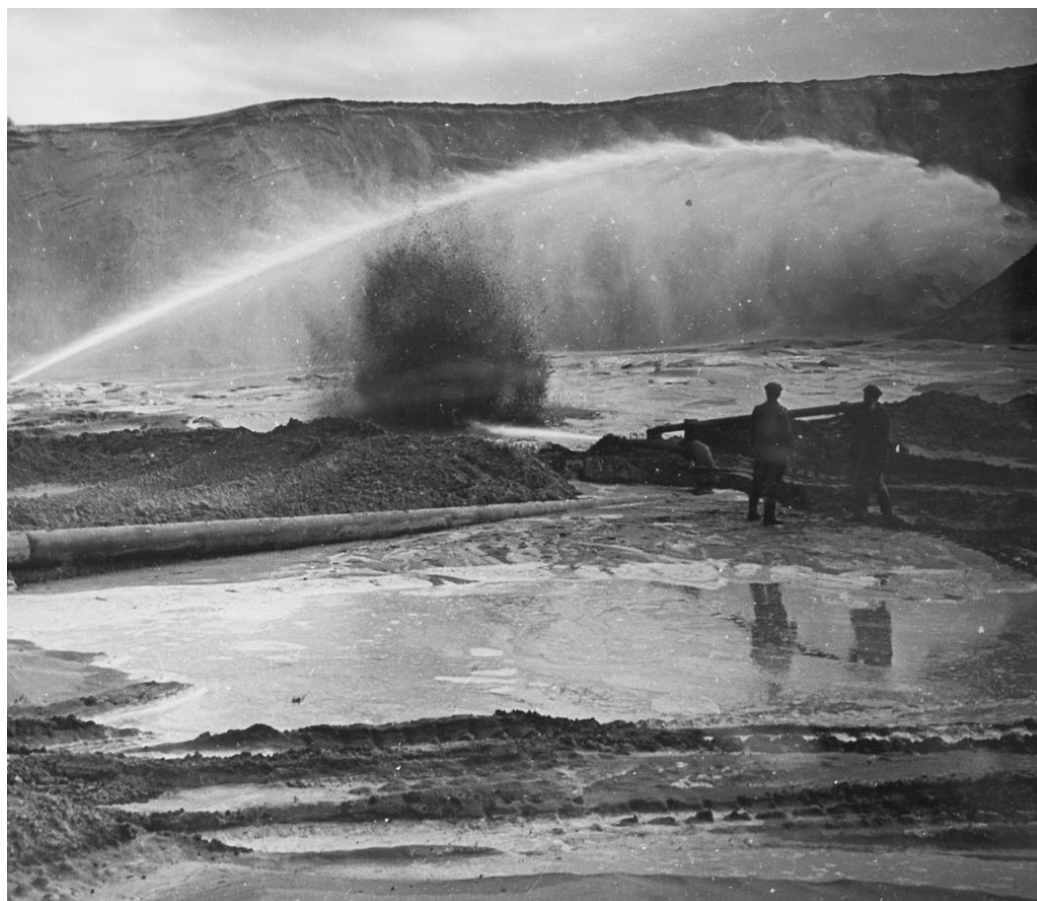
Рис.7. Разработка песка средствами гидромеханизации.
