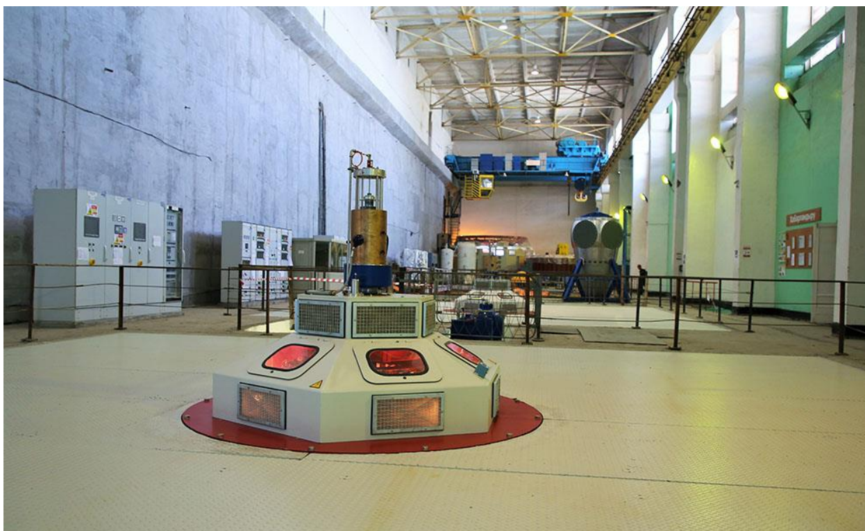
Рис.14. Здание Шардаринской ГЭС.
