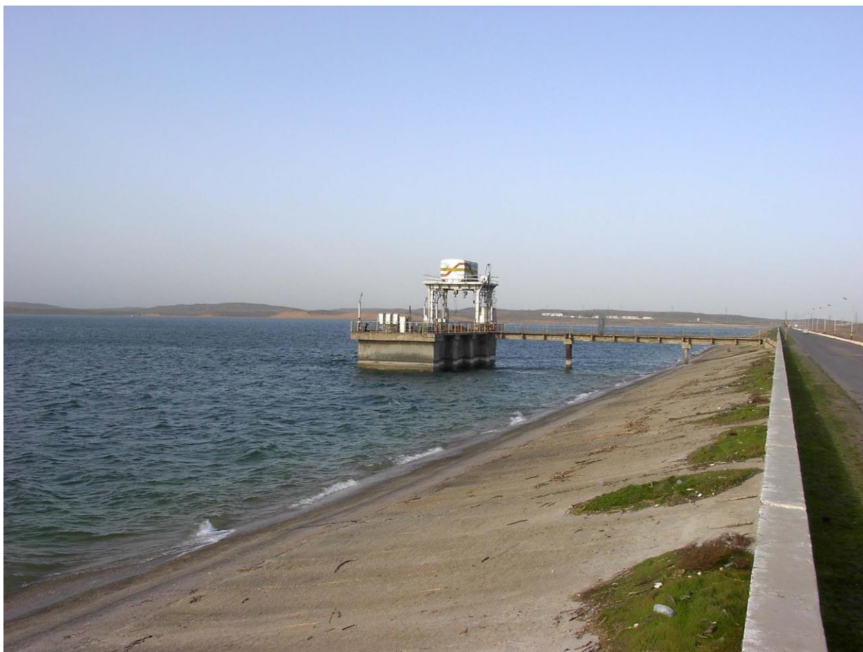
Рис.13. Водосбросное сооружение плотины.
