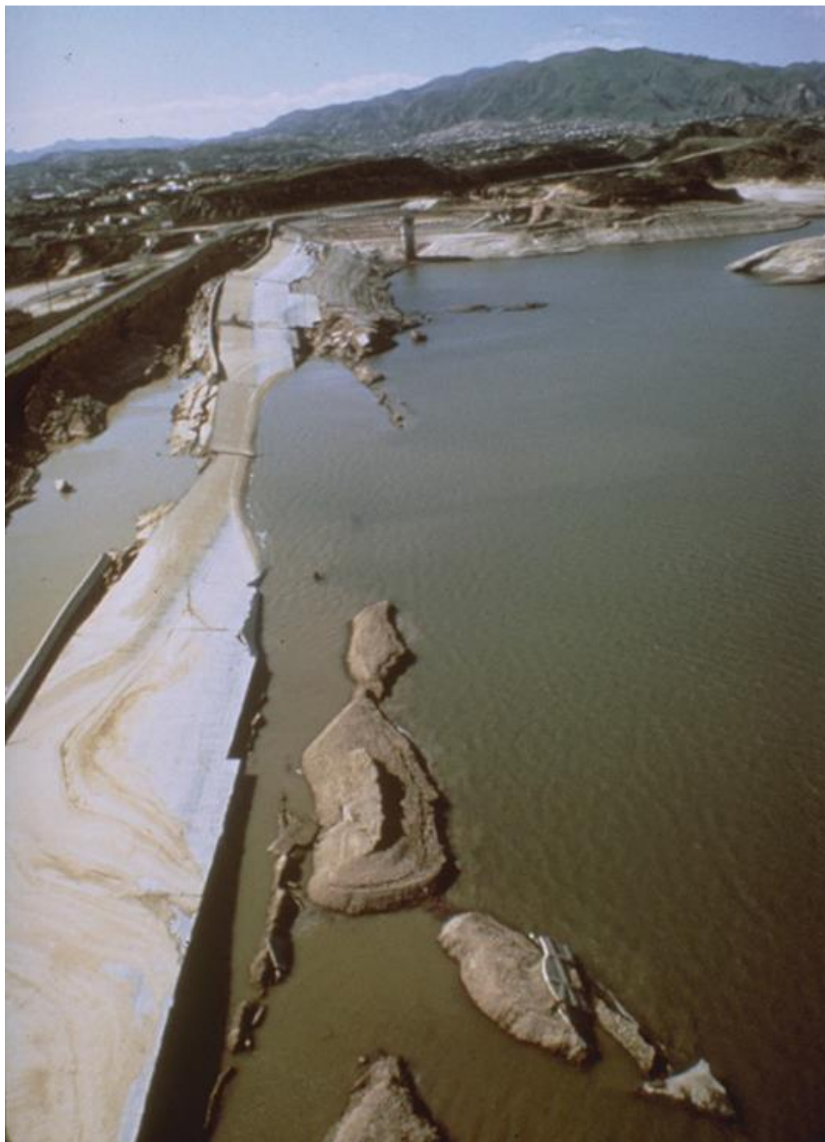
Рис.4.4. Плотина Сан-Фернандо – после землетрясения и обрушение плотины. Вид с левого борта.
