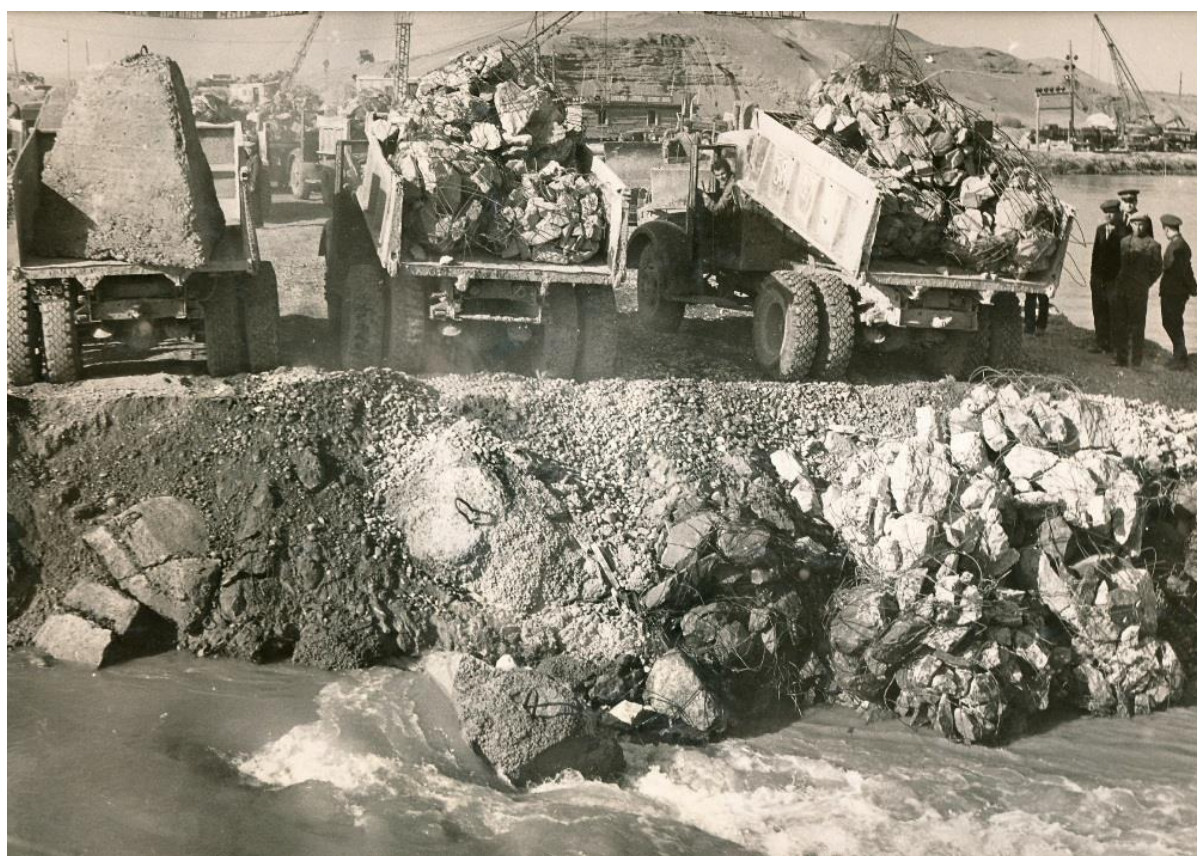
Рис.6.Отсыпка упорной призмы Шардаринской плотины.
