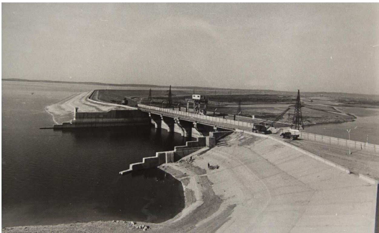
Рис.11. Завершение строительства Шардаринской плотины.
