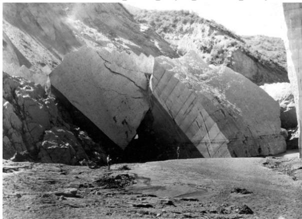
*Рис. 1.4- Обломки плотины Сен-Френсис*
