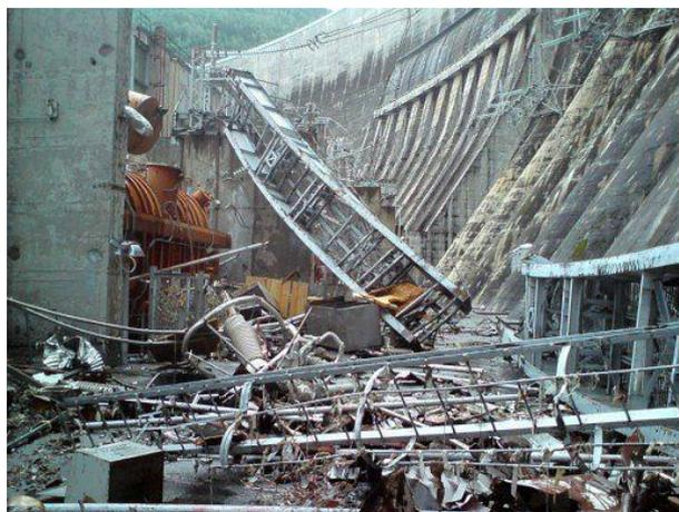
*Рис. 1.3 - Разрушение машинного зала СШГЭС*
