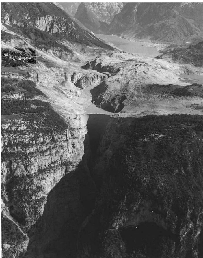
*Рис. 1.7 - Оползень, сошедший в чащу водохранилище Вайонт*
