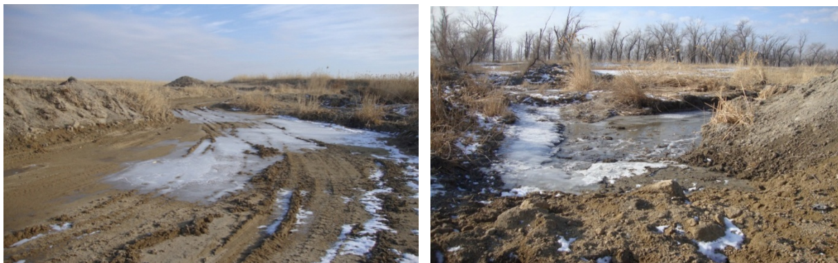
Рисунок 1 - ВХК «Сейдалы» на поверхность выступают грунтовые воды
