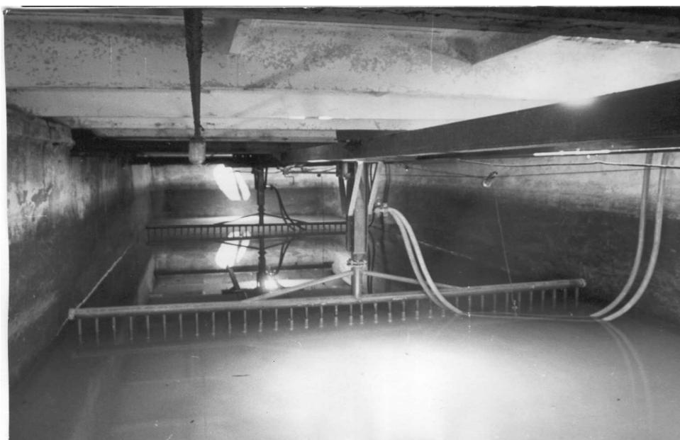
**Рис. 2. Усовершенствованное оборудование по регенерации медленных фильтров**
