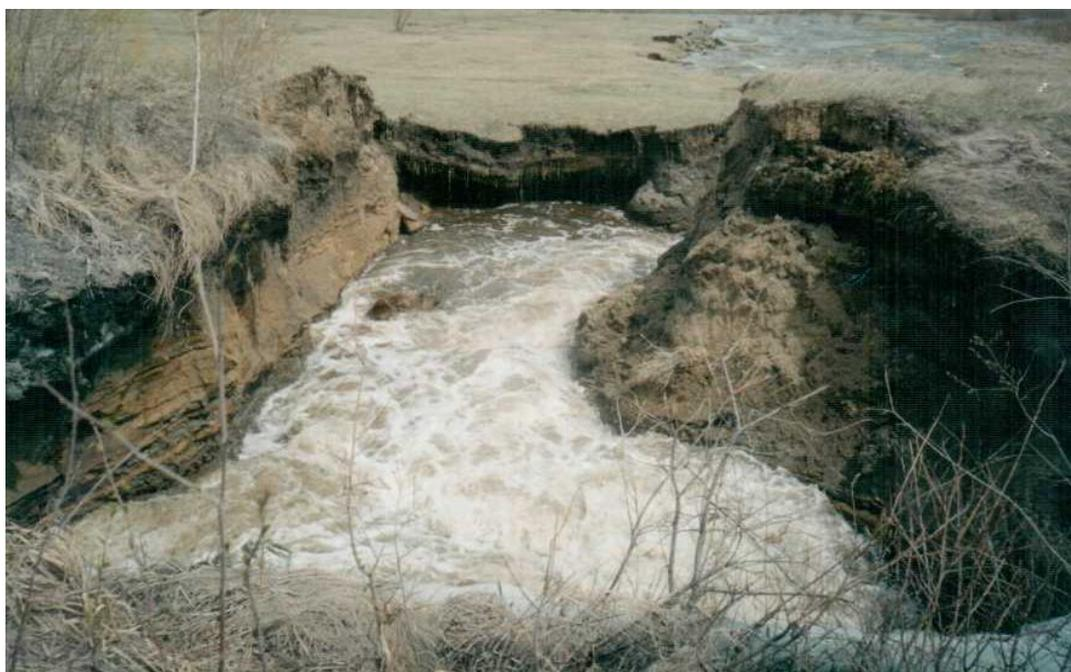
**Рис. 2. Размыв левой бровки и образование прорана на магистральном канале Хамотинской оросительной системы ПК 26+50**
