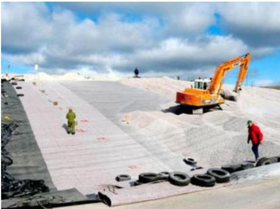
**Рисунок 4 – Реконструкция накопителя отходов с применением геосинтетических материалов**
