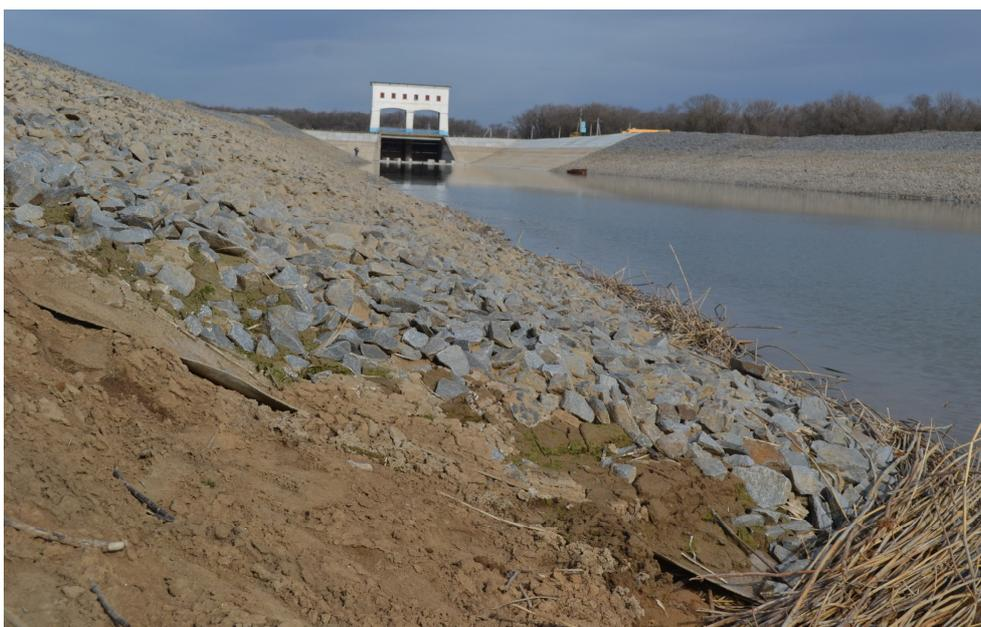
**Рисунок 3 – Участок ДМК с противофильтрационным экраном из бентоматов**
