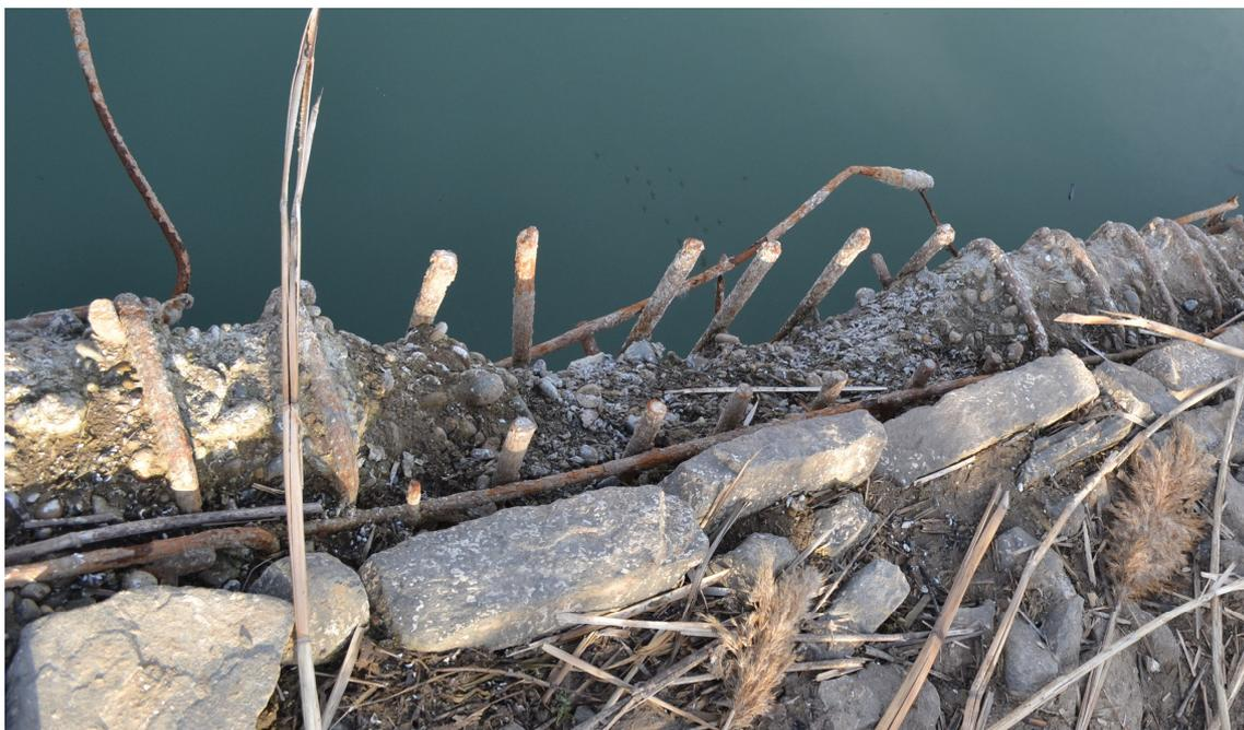
**Рисунок 5 – Оголенная арматура на стенках дюкера**
