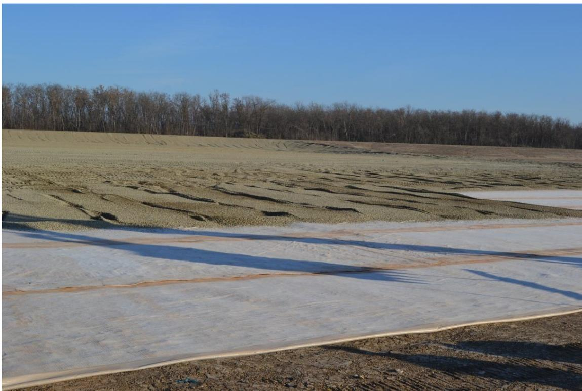
**Рисунок 6 – Противофильтрационный экран с бентоматами и защитным слоем из щебня**
