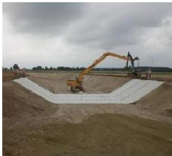
**Рисунок 2 – Реконструкция оросительного канала
