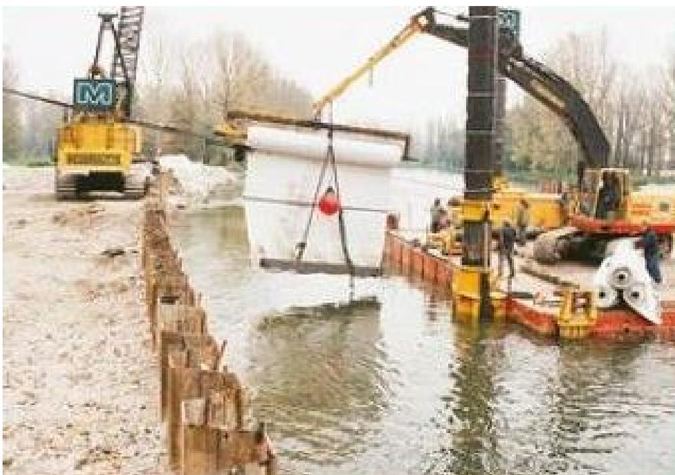
**Рисунок 1 – Укладка бентоматов в канал Дортмунд-Эмс**
