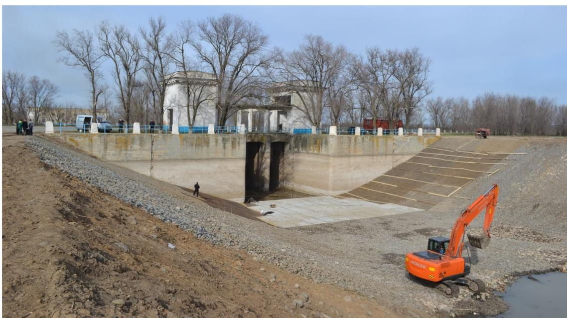
**Рисунок 6 – Реконструкция выходной части дюкера ДМК**
