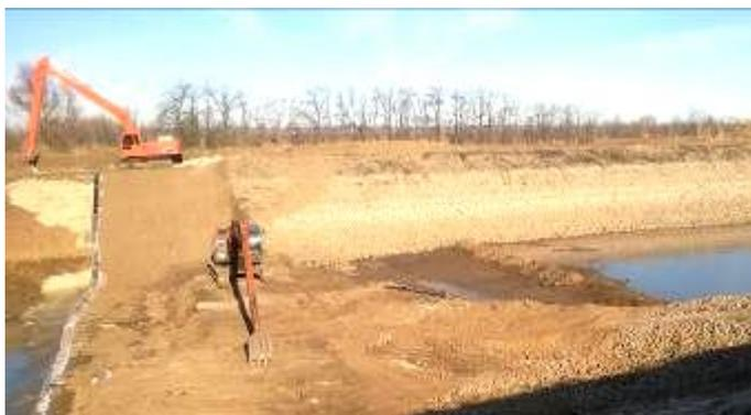
**Рисунок 3 – Реконструкция участка Донского магистрального канала геокомпозитами «БентИзол» (автор фото В. А. Яковлев)**
