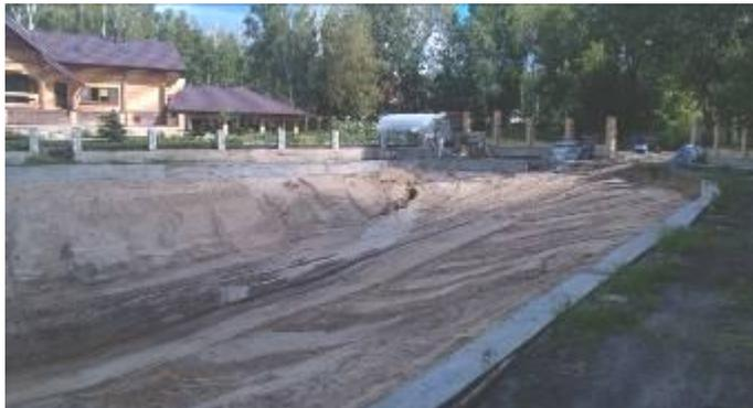
**Рисунок 1 – Строительство рекреационного водоема в г. Казани с экраном из геокомпозитов «БентИзол» (автор фото В. А. Яковлев)**
