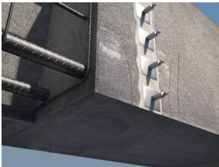
**Рисунок 4 – Общий вид предварительно установленных инъекторов для нагнетания инъекционных материалов в трещину железобетонной конструкции**
