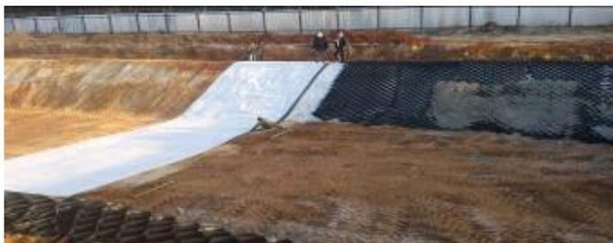
**Рисунок 2 – Комбинированный противофильтрационный экран в г. Екатеринбурге для нужд рыбоводства (автор фото В. А. Яковлев)**
