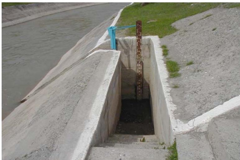
Рис. 3.2. Успокоительный колодец с гидротехнической рейкой
