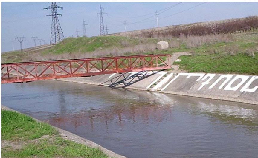
Рис. 3.1. Гидрометрический пост типа «ФР», оборудованный гидрометрическим мостиком
