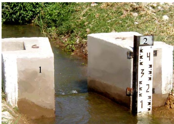
Рис. 3. Водомерный лоток САНИИРИ, подводящая часть
