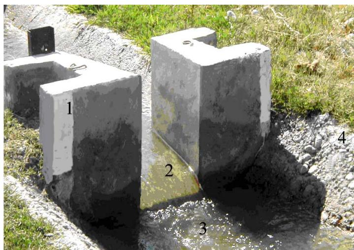
Рис. 4. Водомерный лоток САНИИРИ, отводящая часть:
