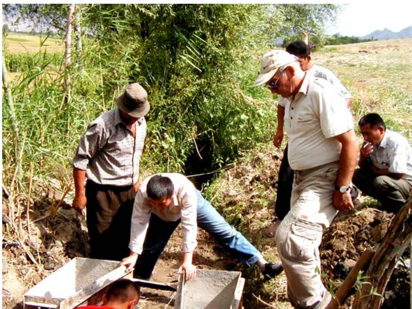
Рис.6. Установка металлической опалубки для отливки лотка САНИИРИ
