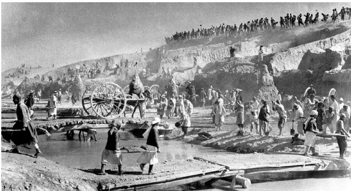
**Рис. 6. Тысячи дехкан были мобилизованы для строительства Большого Ферганского канала осенью 1939 г. (расход  $100 \text{ м}^3/\text{сек}$ , длина 270 км. Он был построен всего за 45 дней методом «хашар»)**
