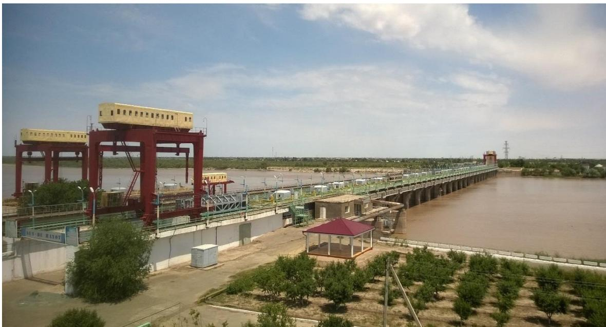
**Рисунок 10. Гидросооружение Тахияташ на реке Амударья в Каракалпакстане (самый большой водослив в Центральной Азии, заверченный в 1974 году) – пропускная способность более 11000 м<sup>3</sup>/с**
