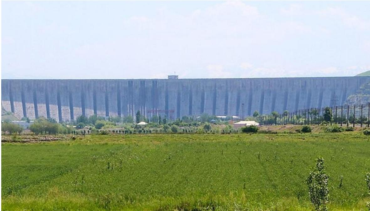
**Рисунок 9. Плотина «Кампир-Рават», построенная на реке Карадарья. Она была спроектирована в 1962 году и была завершена в 1968-1982 годах. Общая длина 1020 м. Плотина массивная бетонная с двойными контрфорсами – 875 м. Максимальная высота 115 м.**
