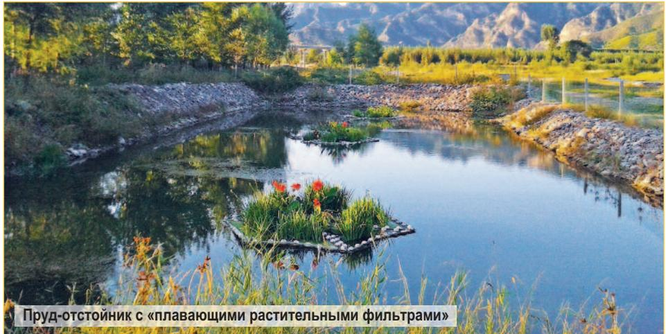
Пруд-отстойник с «плавающими растительными фильтрами»
