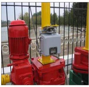
Рис. 6. Установка ДПЗ на винт затвора
