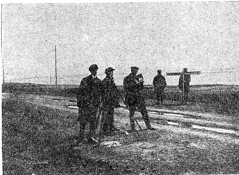
Рис. 2. Проведение испытательного полигона теодолитом Вильда.
