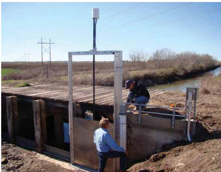
*Автоматизированные затворы, такие как этот, что монтируется здесь, наряду с автоматизированной системой управления, позволят водохозяйственному управлению в режиме реального времени управлять системой, избегая сбросов воды или избыточной подачи воды. Эти затворы были установлены за счет гранта программы «Water-SMART».*
