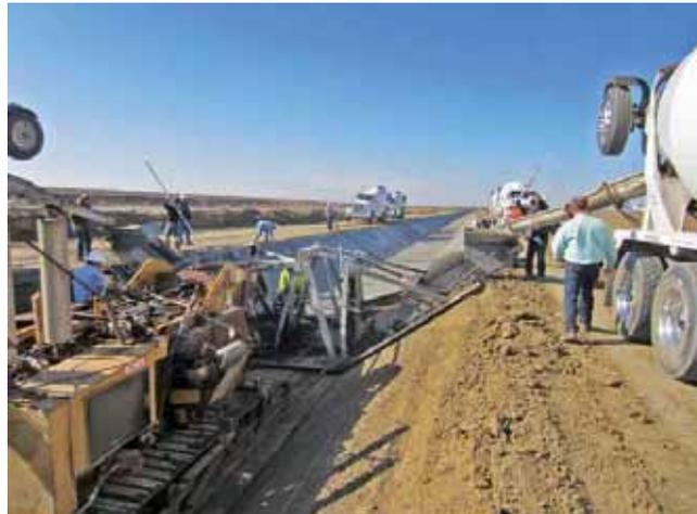
*Облицовка канала «Фаябах», выполняемая управлением оросительных систем в Калифорнии. Проект, который в настоящее время завершен, осуществлен для предотвращения потерь на фильтрацию и управления наносами, подготавливая почву для сотрудничества земледельцев с ДОПР по строительству эффективных систем капельного орошения.*
