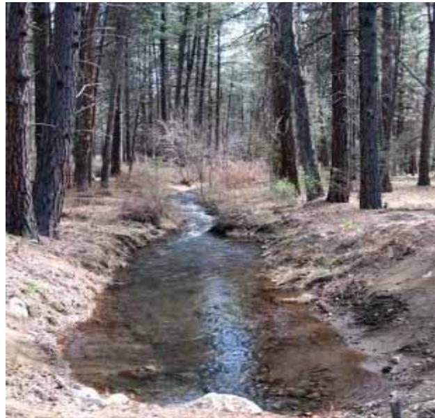
*Необлицованный канал «Дядя Джон» до строительства закрытого трубопровода ирригационным управлением. Этот открытый необлицованный канал использовался для транспортировки воды из ручья Вичус для орошения в бассейне реки Десчутес в штате Орегон.*
