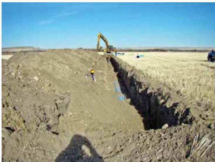
*Для сокращения фильтрационных потерь в своем открытом канале, управление оросительной системой «Форт Шоу» в штате Монтана реконструирует участок этого канала в закрытый трубопровод. Проект выполняется в 2011 году с помощью гранта программы «Water-SMART», внося свой вклад в достижение приоритетных целей Министерства внутренних дел по водосбережению.*
