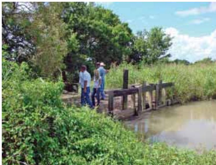
*Существующие затворы на сооружениях канала Прибрежной оросительной системы в Техасе. Ручное управление этими затворами требует, чтобы рабочий обходил всю 300-мильную систему канала, что ограничивает возможности водохозяйственного управления обеспечивать поставки точных объемов воды, необходимой фермерам.*
