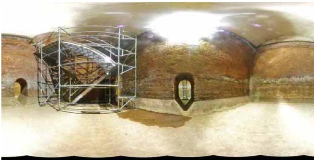
*Цистерны на участке национальной исторической достопримечательности Сан-Хуана в Пуэрто-Рико. Оригинальные цистерны были восстановлены и являются частью системы сбора и очистки дождевых вод для использования на участке, экономя затраты на водоснабжение*
