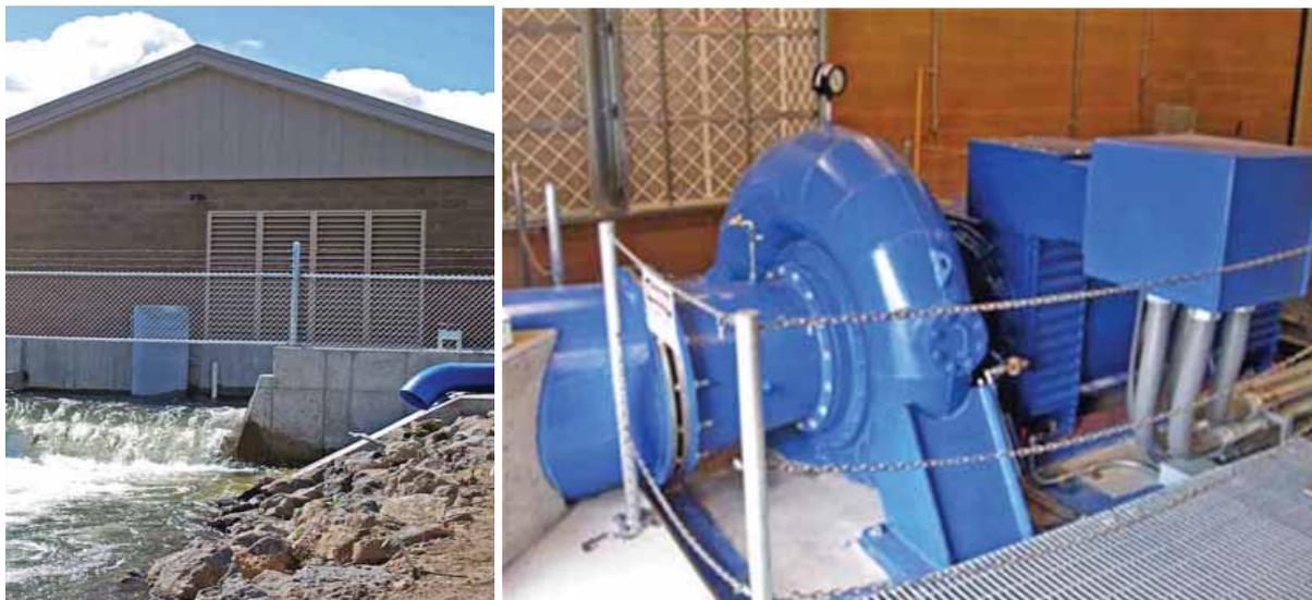
*Электростанция «Пондероса», построенная управлением оросительных систем «Свэлли» в Оригоне в рамках финансирования ARRA (слева). Электростанция – компонент проекта увеличения использования возобновляемой энергии и повышения эффективности водопользования – расположена в здании на существующем канале и использует перепад в отметках воды на этом участке.*
