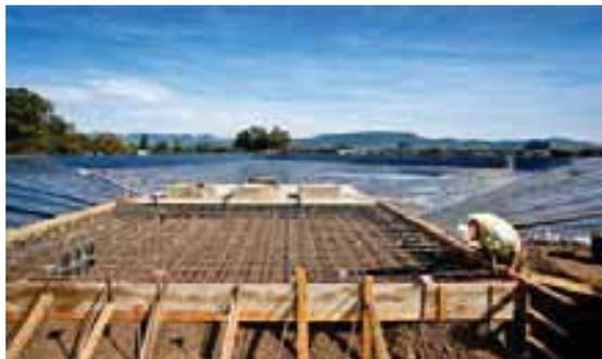
*Строительство резервуара очищенной воды емкостью 100 акро-футов санитарной службой округа Санома, один из титульных проектов XVI для снижения зависимости от использования подземных вод.*
