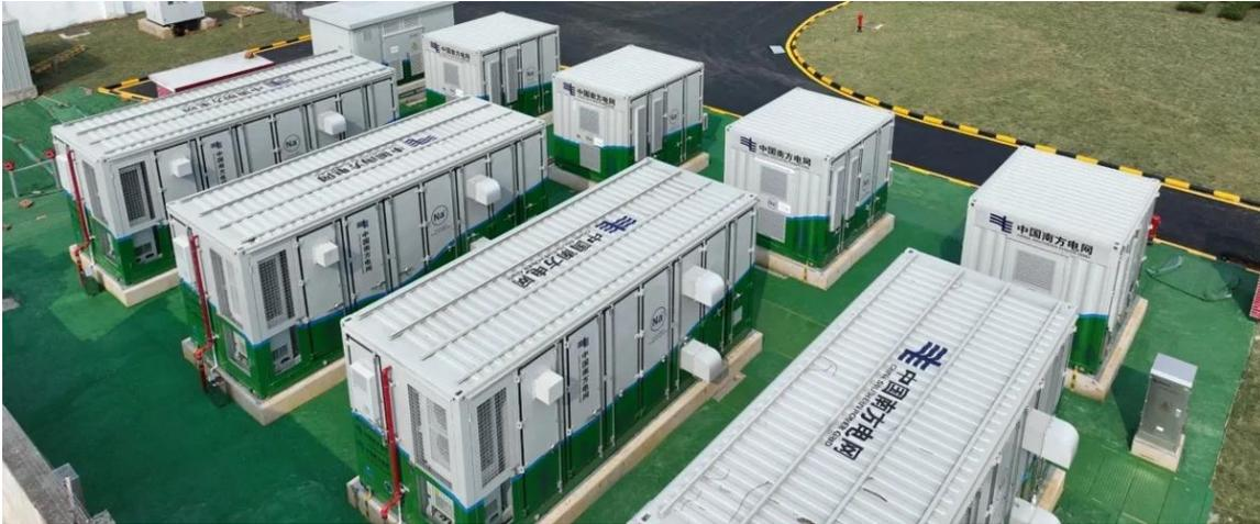
По данным компании, станция хранения энергии мощностью 10 МВт оснащена натрий-ионными аккумуляторными элементами емкостью 210 А ч, которые можно заряжать до 90% за 12 минут. Система состоит из 22 000 ячеек.
