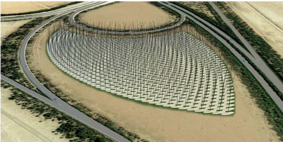
Проект Windstalk в Масдаре от компании Atelier DNA состоит из 1203 столбцов высотой 55 м, закрепленных на бетонных основаниях диаметром от 10 до 20 м. Столбы диаметром 30 см у основания и 5 см сверху освещаются при помощи светодиодов, светящихся ярко или тускнеющих в зависимости от силы ветра. Ночью вся установка выглядит очень впечатляюще.
