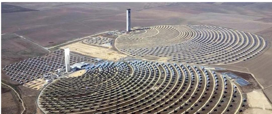
Солнечная тепловая (концентрированная) и обычная (фотоэлектрическая) энергия получают энергию от солнца, но делают это по-разному. Тепловые системы улавливают солнечное тепло, а не свет. Они используют зеркала, чтобы сфокусировать солнечные лучи на приемнике и превратить солнечное излучение сразу в тепло — для отопления домов, воды или в промышленности.
