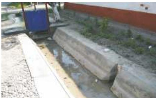
Рис. 30. Фиксированное русло с равномерной нишей
