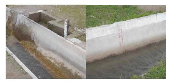
Рис. 8. Градуированный параболический лоток а) с успокоительным колодцем б) с расходомерной шкалой
