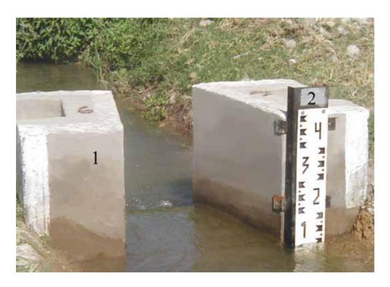
Рис. 3. Водомерный лоток САНИИРИ, подводящая часть 1 – входные открылки, 2- гидротехническая рейка
