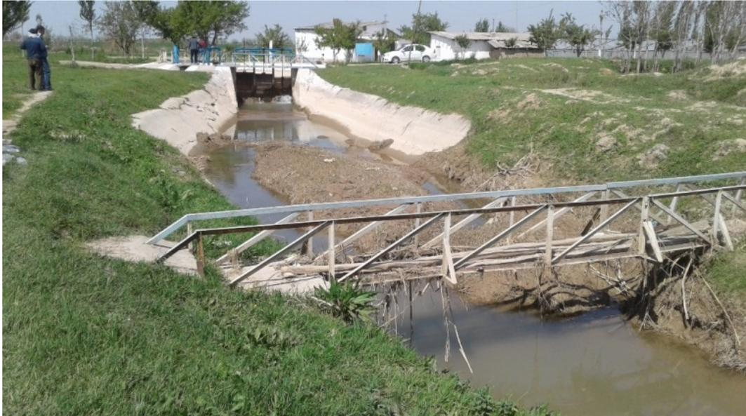
**Рис 2. Отложения наносов в подводящем участке гидропоста**
