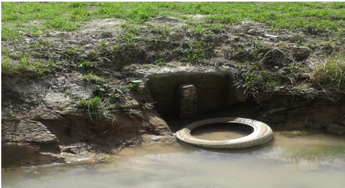
**Рис 4. Уровнемерная ниша с рейкой на откосе канала забитая наносами**
