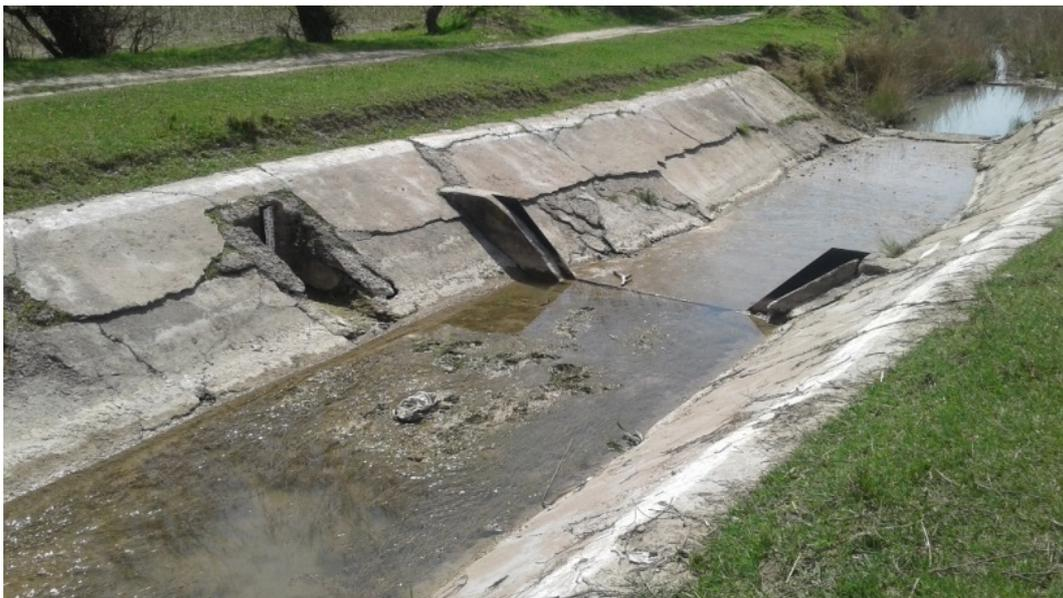
**Рис 3. Гидропост с водосливом Иванова, с рейкой в бетонной нише**
