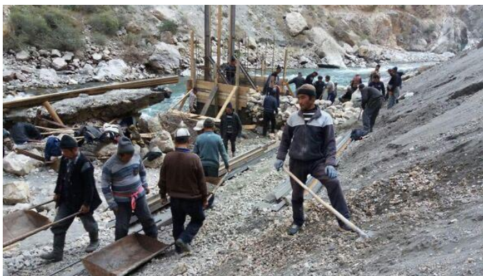
Рис. 2. Ашар при строительстве моста
