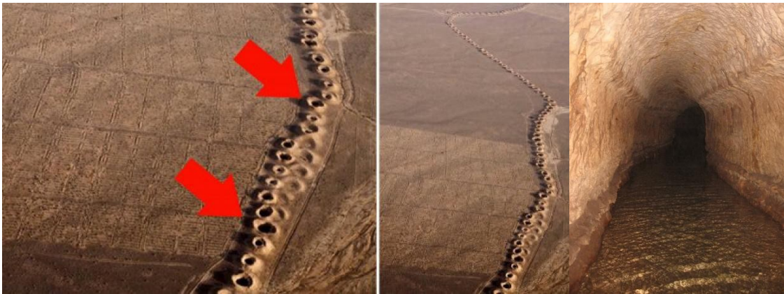
Рис. 3. Пример системы очистительных колодцев по пути следования подземного водовода – кариза Источник: Мукимов и соавторы, 1996; Мамаджанова, 2017
