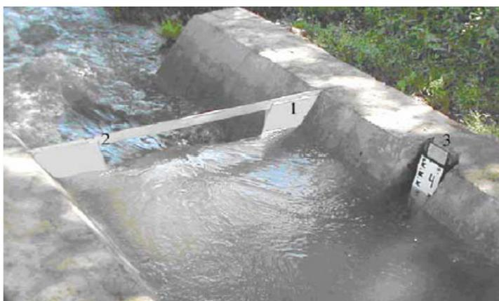
Рис.7 Водослив Чиполетти с водомерной рейкой (поз. 3)
