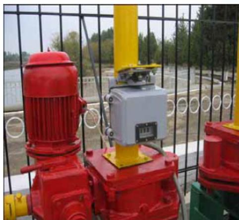
Рисунок 8 Датчик ДПЗ
